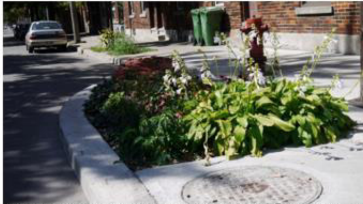
Aménagement d'une avancée de trottoir plantée aux abords d'un passage piéton
