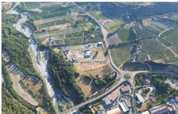
Vue aérienne de la ZAE du Grand Tilleul à Nyons.
