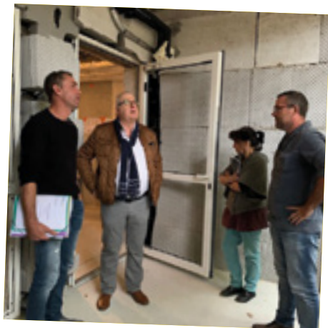
Début des travaux/Grèche de Mirabel-aux-Baronnies
