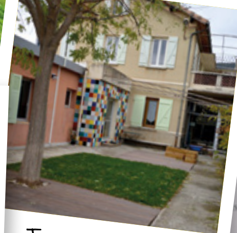
Travaux à la Maison Couleur à Nyons
